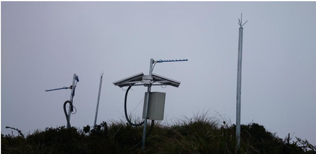
Figura 92. Instalación de repetidor CERRO BRAVO.
