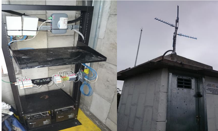
Figura 3. Caseta repetidor PITAYO.
