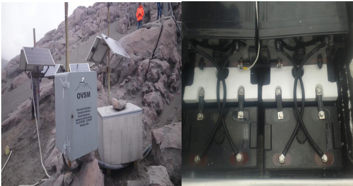
Figura 4. Instalación banco baterías estación multiparamétrica OLLETA2.
